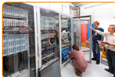
Einrichtung des neuen Serverraumes
